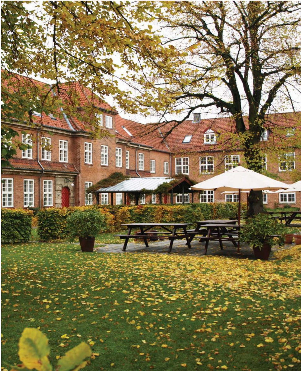
Avedørelejren er opført mellem 1911 og 1913 efter tegninger af arkitekt Helge Bojsen-Møller (1874-1946) og udvidet to gange. Bojsen-Møller havde gjort sig en del erfaring med større, offentlige anlæg som hospitaler og skoler, og til Avedøre lod han sig også inspirere af ældre kasernebyggeri, især Kastellet i København. Foto: Dansk Bygningsarv.
