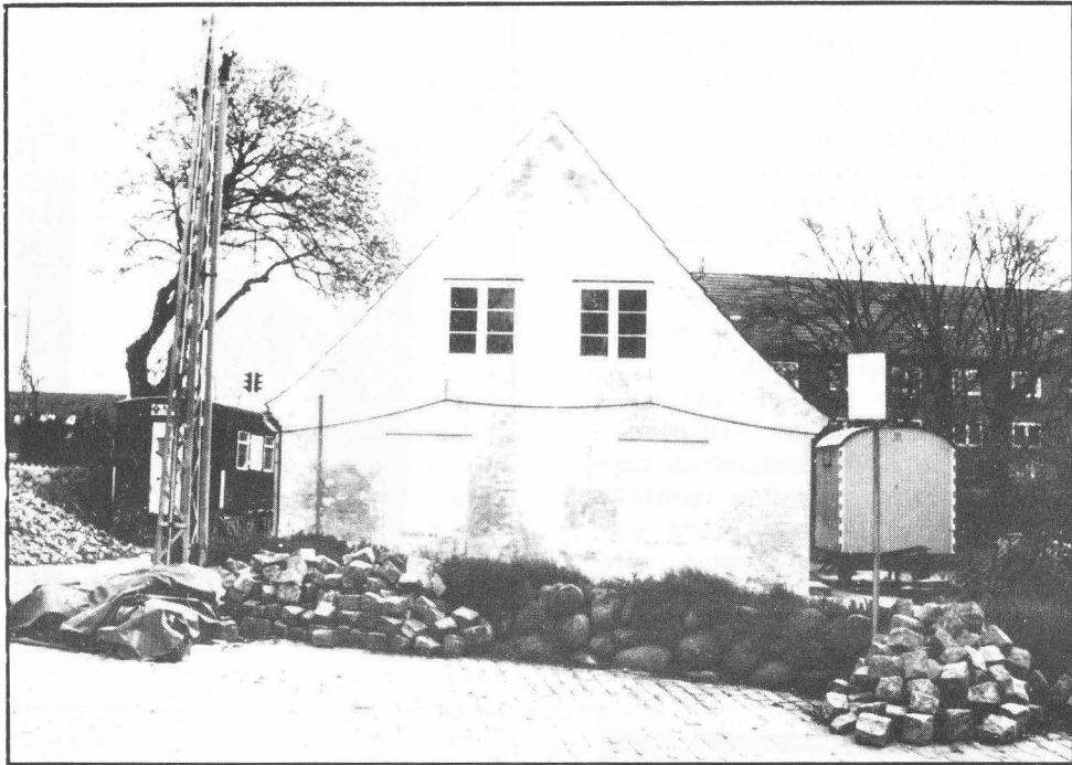
Vest-gavlen med nye vinduer, 1988.
