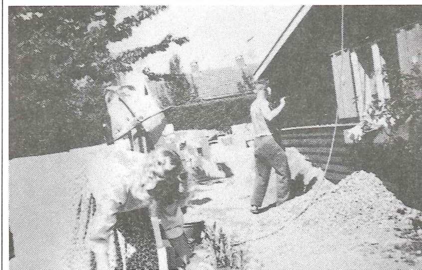
Der arbejdes på slottet
