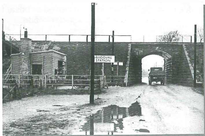
Viadukten fra 1880, set ca. 1935 ..... Foto HLA.
