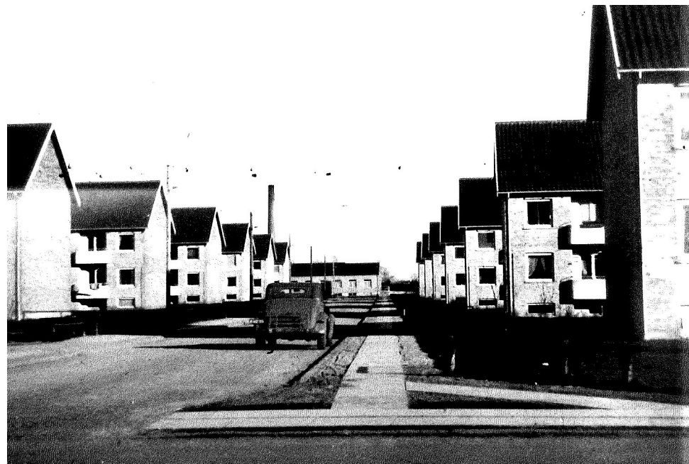
Det færdige byggeri set mod Kalkager (ca. 1951)
