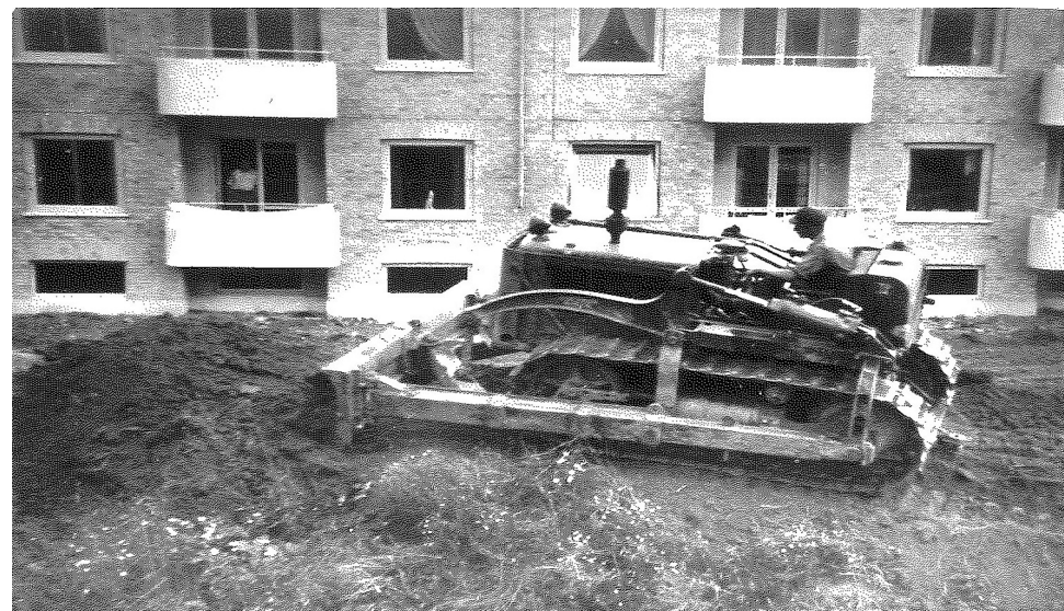
Bulldozeren planerer efter færdiggørelsen af Danalund(ca. 1951)
