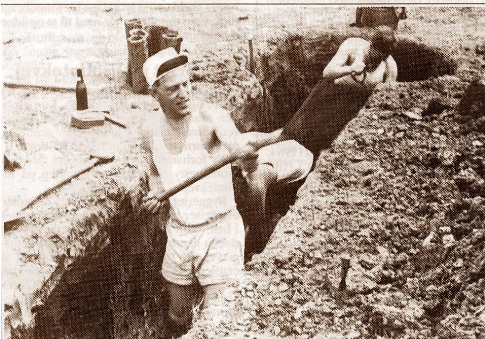
Hårdt arbejde ved håndkraft. Sådan blev HBC hallen til.
