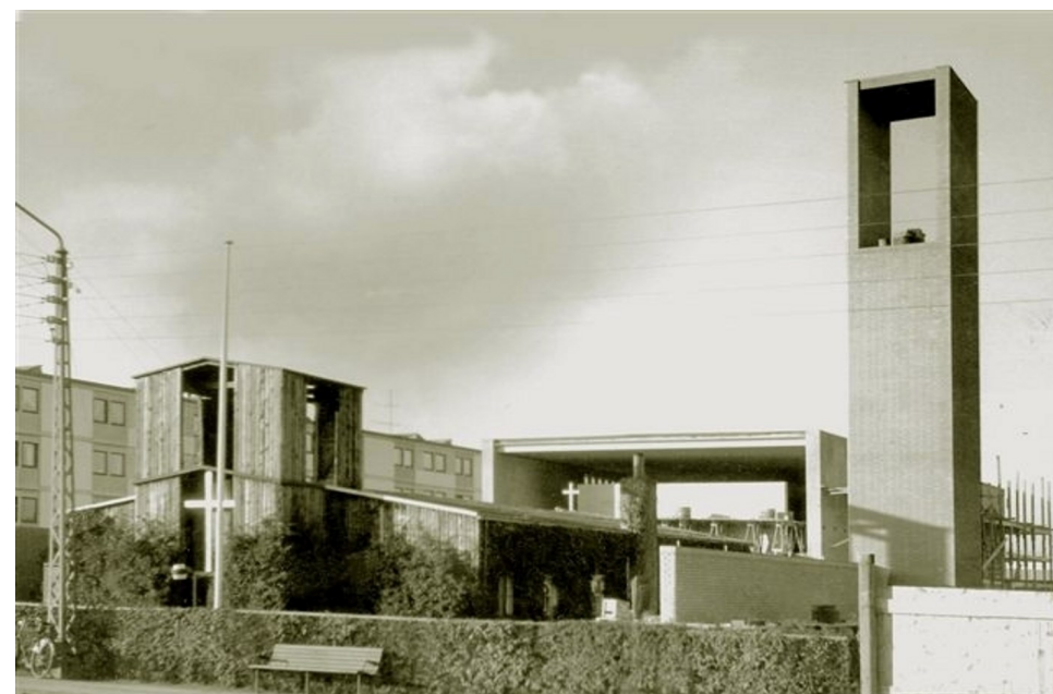
Den nye Strandmarkskirke bygges, den gamle trækirke forrest.
