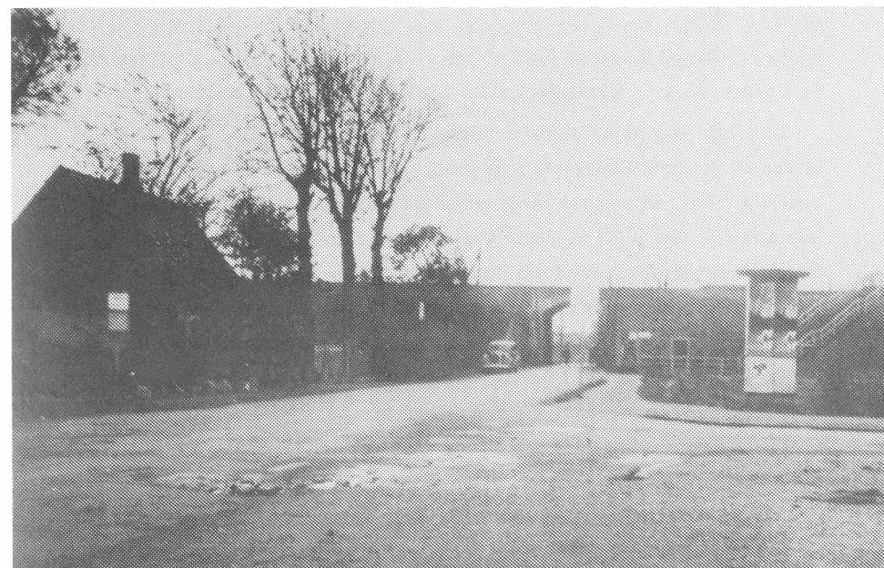
JERNBANEVIADUKTEN OVER HVIDOVREVEJ I 1938
