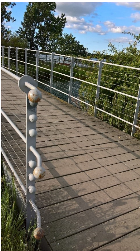
Broen over Mørtelværksrenden Foto: Inga Vikjær
