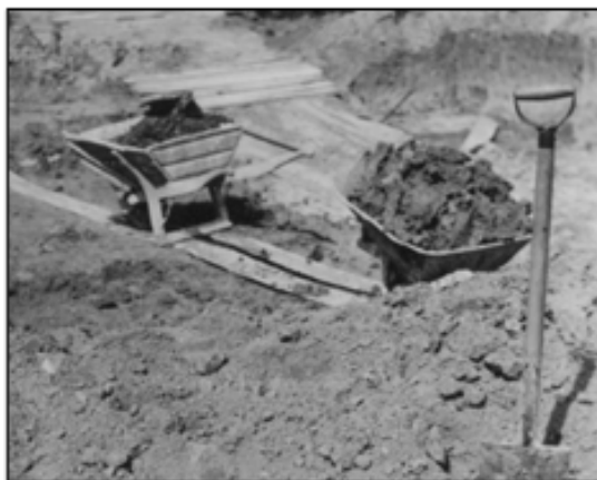
Kælder under hele huset, så der skulle graves ud med trillebør, ikke noget med hejsskraner den gang.
