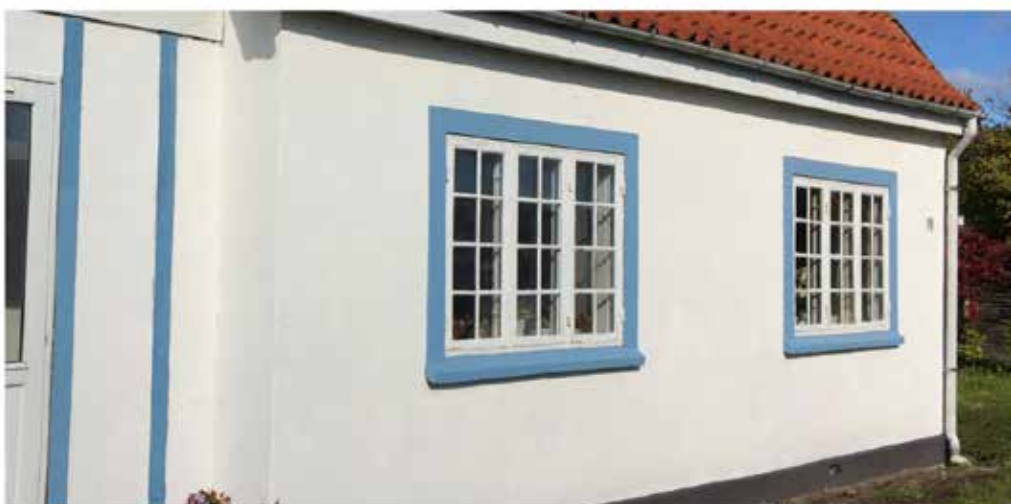
Facade før og efter renovering - Foto: Bente Zinck
