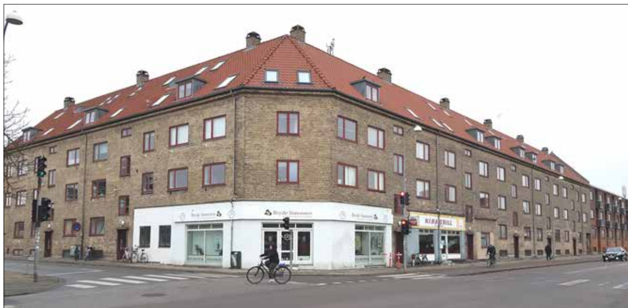
Foto: Fra venstre mod højre Vojensvej 2-4, Hvidovrevej 86 – 88 A samt Hvidovrevej 82- 84 A. Marts 2021. Fotograf: Jens Frederik Jørgensen
