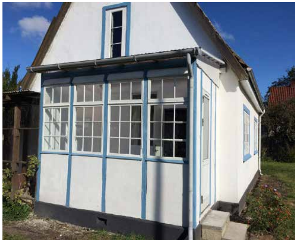
Nyrenoveret facade 2016 - Foto: Bente Zinck
