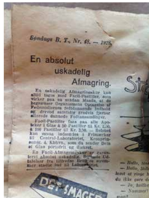
Avisen der er blevet brugt som isolering i dørkar- men - Foto: Bente Zinck
