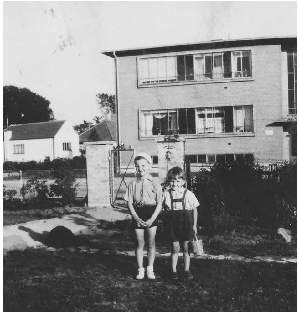
På Kløverprisvej 5-11 ligger fire boligblokke med hver fire lejligheder fra 1939. De blev opført i tidens funktionelle arkitektur og havde fra start både centralvarme og trykvand i hanerne. Ligesom Solsiden på hjørnet af Kløverprisvej og Hvidovrevej var arkitekten A.B. Thomsen. Billedet er i øvrigt taget i haven til Kløverpris 12, hvor familien Frederiksen byggede bolig og Holmegårdens Kolonial. Her kunne de nye beboere i kvarteret købe så forskellige varer som kaffe fra Uganda og islandske sild. Forstadsmuseet.
